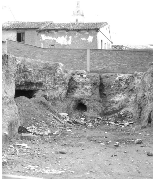
Foto nº 12: Excavación del solar, en el que se aprecian diferentes galerías que se daban a distintas profundidades (Tordesillas)
