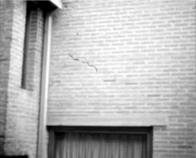
Foto 21: Grieta en esquina debida a junta dilatación entre dos cuerpos de edificio
