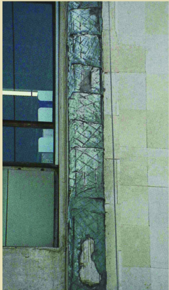
Reparación por capas de un pilar muy dañado.
