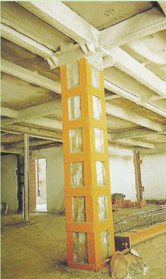
Refuerzo de un pilar de hormigón armado mediante la adición de ángulos metálicos.
