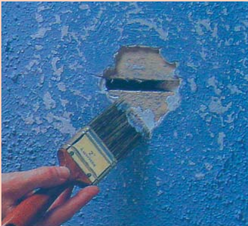
Aplique una capa abundante de cola de látex sobre los bordes del agujero y en el soporte de la base.
