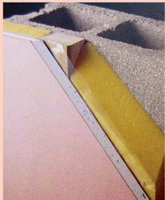
Coloque una barrera de vapor de polietileno de 0,15 mm en el lado del aislante más cálido en invierno.
