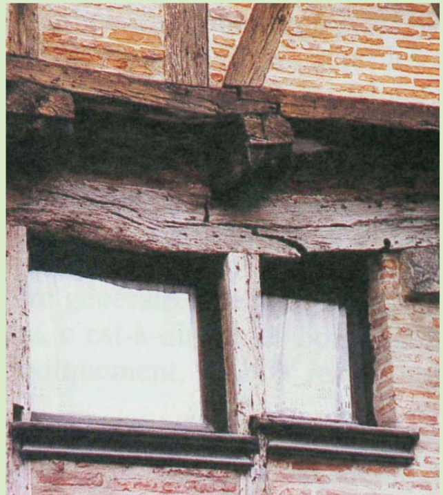
Dos ejemplos de vigas de madera que han perdido parte de su capacidad portante. Es importante observar que la madera es el único material que deforma de esta manera sin colapsar en el plazo inmediato.
