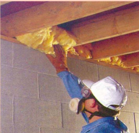
Aísle las viguetas de la parte superior de los muros del sótano rellenando los huecos con aislante de fibra de vidrio, sin apretar.
