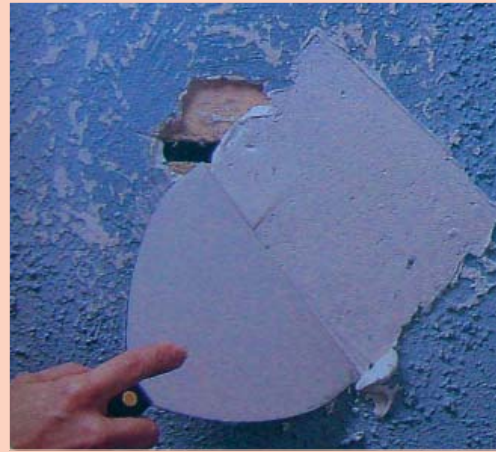
Rellene el agujero con una sola capa de emplaste.
