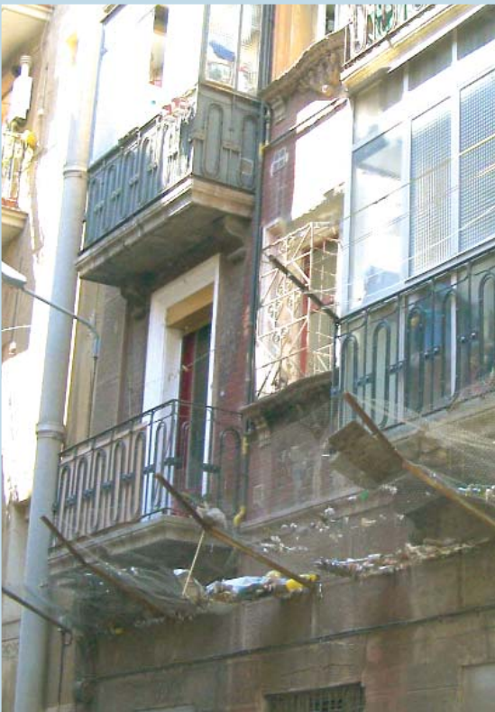
Los desprendimientos de revocos en cascos antiguos de calles estrechas obligan a tomar medidas de seguridad para paseantes y automóviles.
