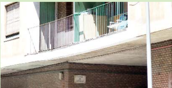
Flechado de un forjado de un edificio que cruza una calle.
