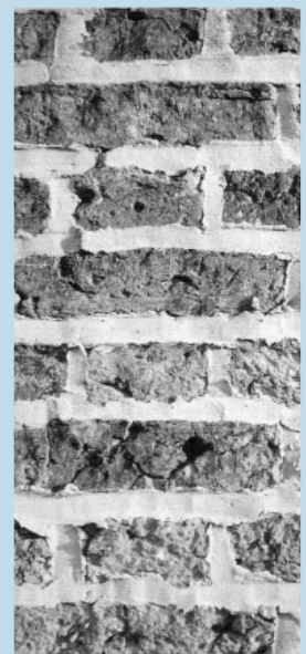
Remoción de mortero deteriorado y preparación de la superficie para la aplicación del sellador.
