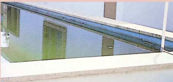
Un caso particular de asiento de una piscina. Nótese la divergencia entre el borde de la piscina y el filo del agua.
