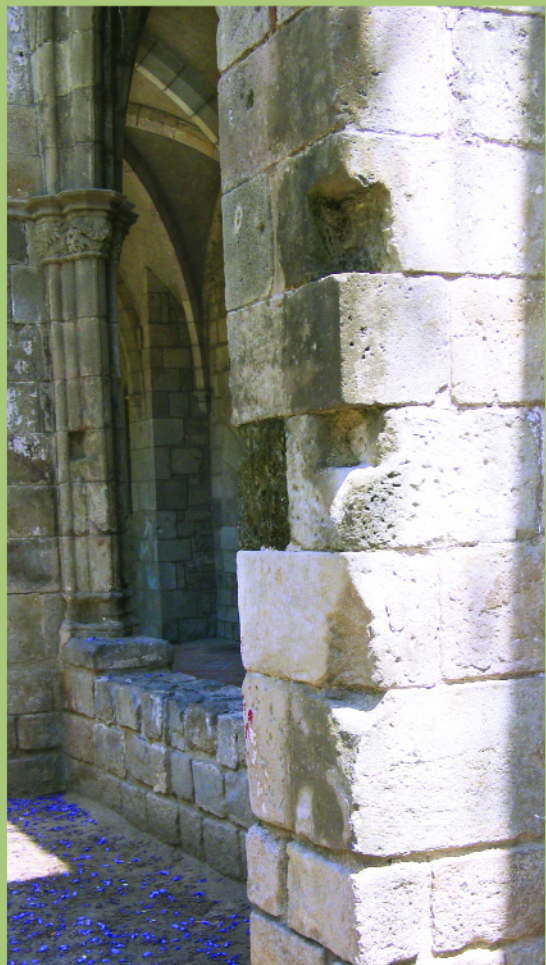
Desgaste del material pétreo debido a la erosión eólica y de lluvias. Este fenómeno se acrecenta en piedras porosas y en situaciones edilicias de gran exposición.
