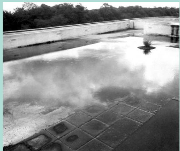
La poca o nula pendiente de la cubierta, un drenaje insuficiente o falta de mantenimiento producen este tipo de situaciones donde las filtraciones no tardan en aparecer.
