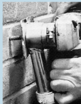
Remoción de mortero deteriorado y preparación de la superficie para la aplicación del sellador.
