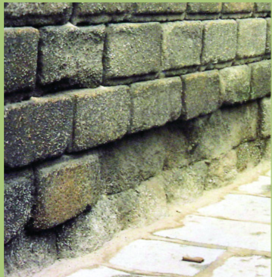
El viento, el agua y el hielo se han combinado intermitentemente para erosionar este muro de piedras. Las partes bajas y altas siempre son las más castigadas por los agentes atmosféricos.
