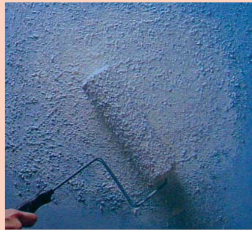
Reproduzca la textura de la superficie, utilizando pintura texturada o masilla. Cubra la zona con una capa de imprimación y pinte encima.
