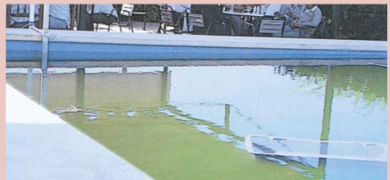
Un caso particular de asiento de una piscina. Nótese la divergencia entre el borde de la piscina y el filo del agua.
