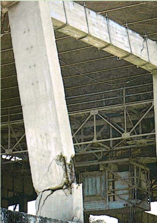
Vuelco de un pórtico de hormigón armado por cesión del pilar.
