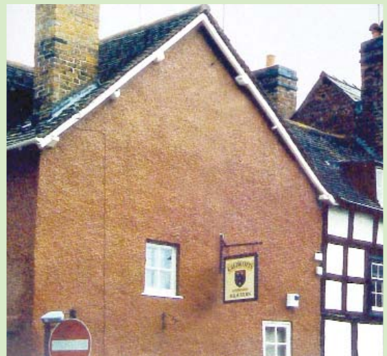
Realización de termografía de una casa para conocer su estructura oculta. Es un método de diagnosis sencillo y muy útil.
