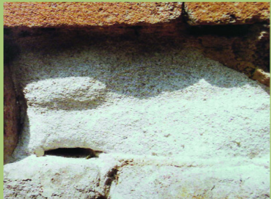
Arenzación del material pétreo: una consecuencia de la hidratación de sales solubles depositadas o contenidas en la piedra.
