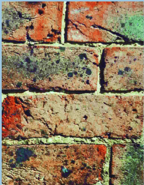
Ladrillos antiguos de masa heterogénea y calidad variable.
