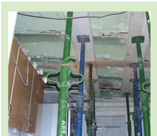
Típico caso de un forjado apuntalado previo a las tareas de refuerzo y sustitución de la estructura en déficit.
