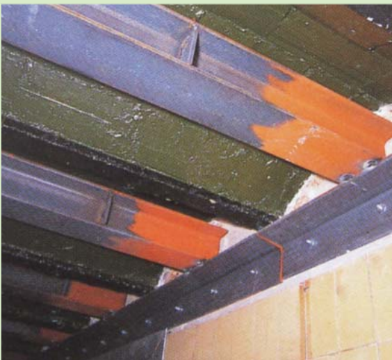
Ejemplos de operaciones de refuerzo con perfiles metálicos de forjados cerámicos.
