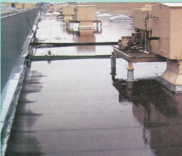
La poca o nula pendiente de la cubierta, un drenaje insuficiente o falta de mantenimiento producen este tipo de situaciones donde las filtraciones no tardan en aparecer.
