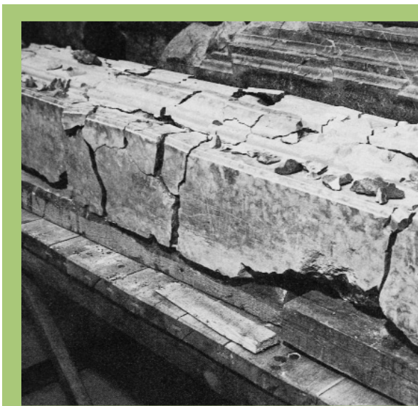
El devastador efecto del ciclo hielo-deshielo en una pieza.
