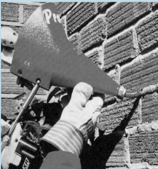
Sellado de juntas deterioradas mediante la aplicación de productos sintéticos..
