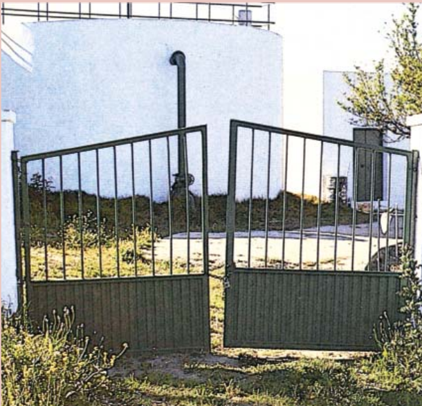
La expansividad del terreno ha provocado el vuelco de estos dos elementos de poco peso. El primero es un pilar de mampostería que sostiene la reja de un portón y el segundo es otro pilar que alberga medidores eléctricos.
