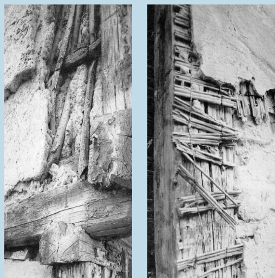
Muros de tierra y paja erosionados por los agentes atmosféricos.
