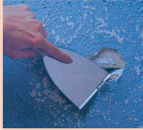
Elimine el yeso suelto o blando de los bordes.
