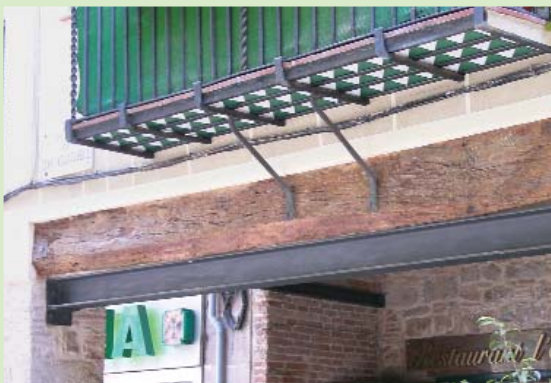
Operación de refuerzo de una viga de madera mediante la adición de un perfil metálico en todo su largo.
