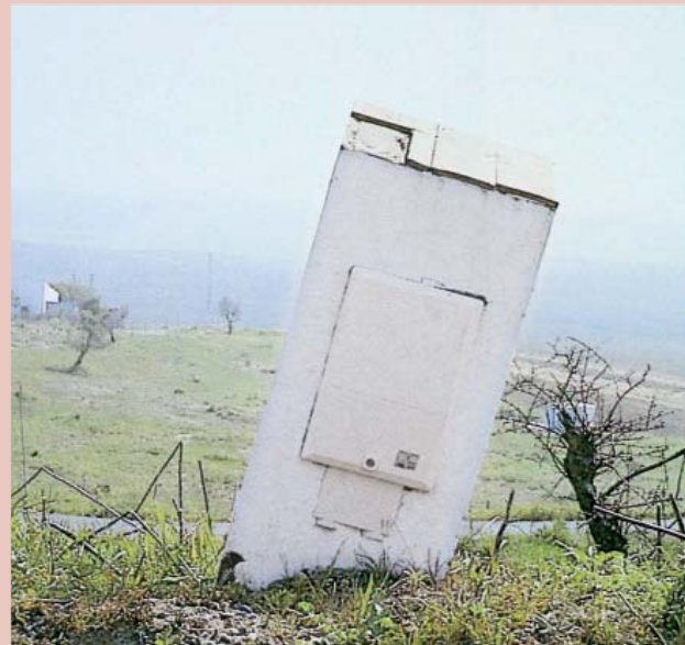
La expansividad del terreno ha provocado el vuelco de estos dos elementos de poco peso. El primero es un pilar de mampostería que sostiene la reja de un portón y el segundo es otro pilar que alberga medidores eléctricos.
