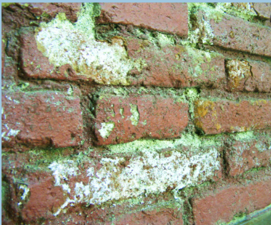
Eflorescencia blanca de origen sulfático.
