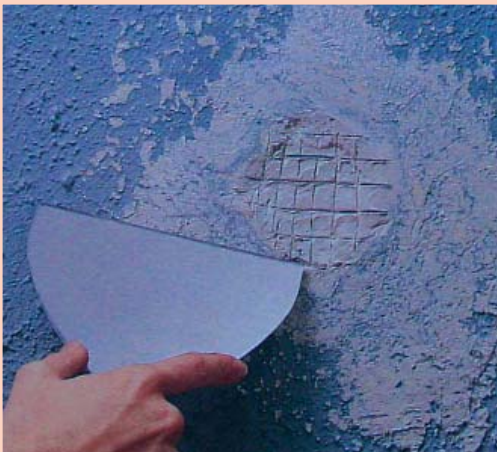
Llene los agujeros más profundos con una primera capa superficial y marque una trama cruzada en el yeso húmedo. Aplique luego una segunda capa.
