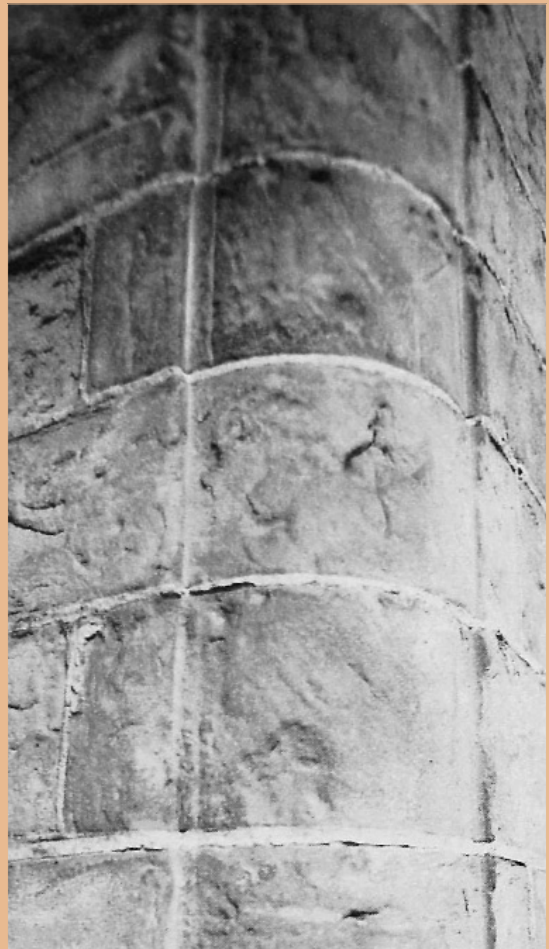
Buena decisión de diseño, el redondeado de esta arista expuesta a roces disminuye su erosión.
