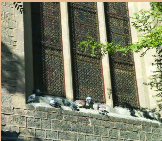
Las deposiciones de las aves contienen componentes con un pH ácido, lo cual ataca no sólo partes mecánicas sino también a elementos pétreos y arcillosos.
