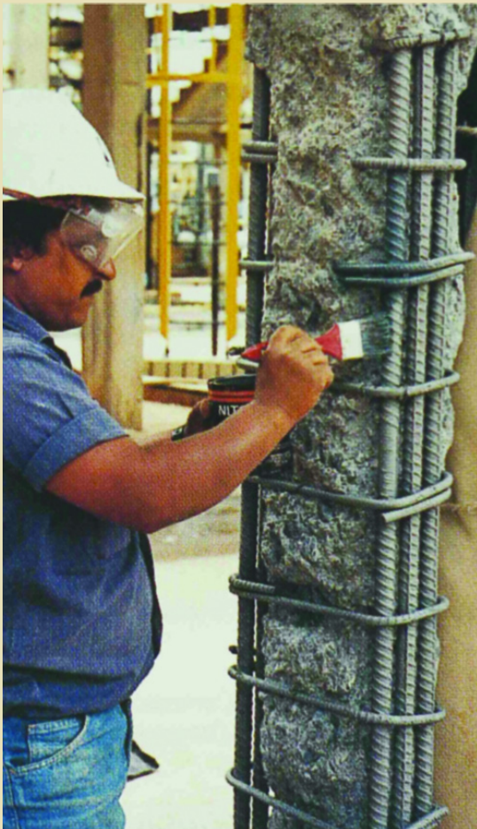
Limpieza y preparación de un pilar de hormigón armado para su posterior recrecido.
