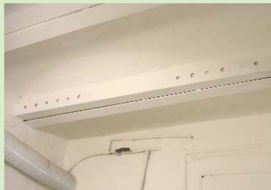
Refuerzo parcial de una viga de madera interior que perdió parte de su capacidad portante debido a una pudrición.
