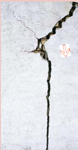
En un asiento diferencial el edificio puede descender por partes con la aparición de grietas características (izquierda) o bien girar monólicamente sobre un eje (derecha).
