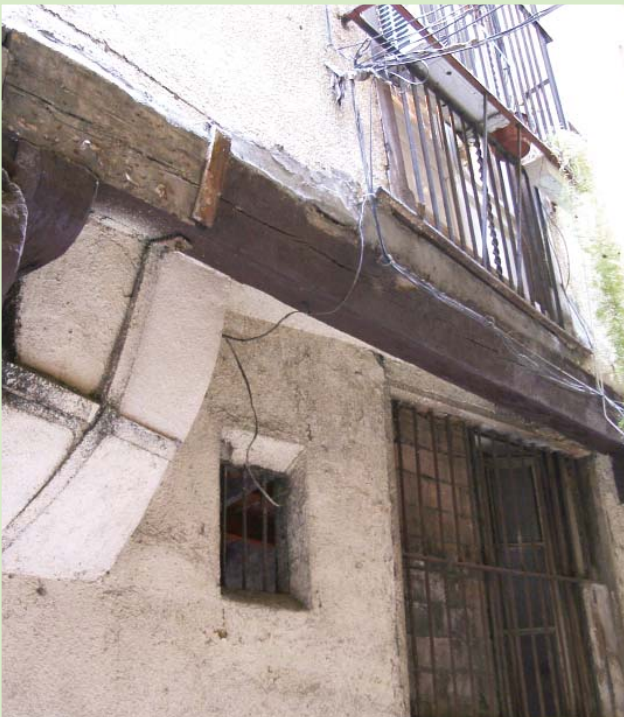
Dos ejemplos de vigas de madera que han perdido parte de su capacidad portante. Es importante observar que la madera es el único material que deforma de esta manera sin colapsar en el plazo inmediato.
