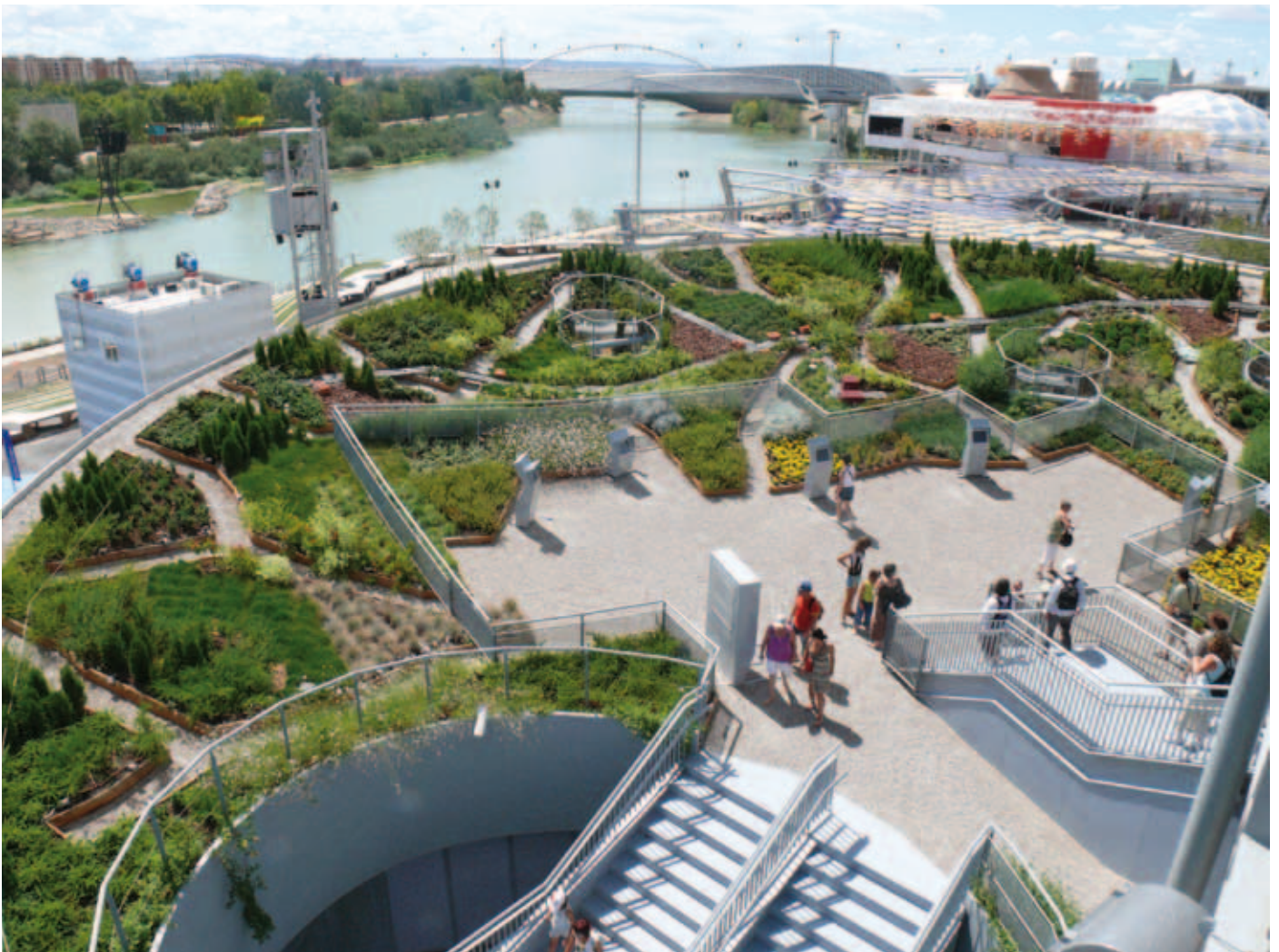
Cubiertas verdes en la EXPO, Zaragoza
