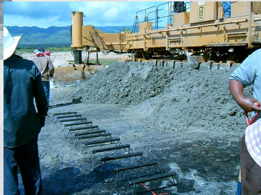
En la construcción de las losas se emplea un pavimentador con un ancho de 11.50 m
