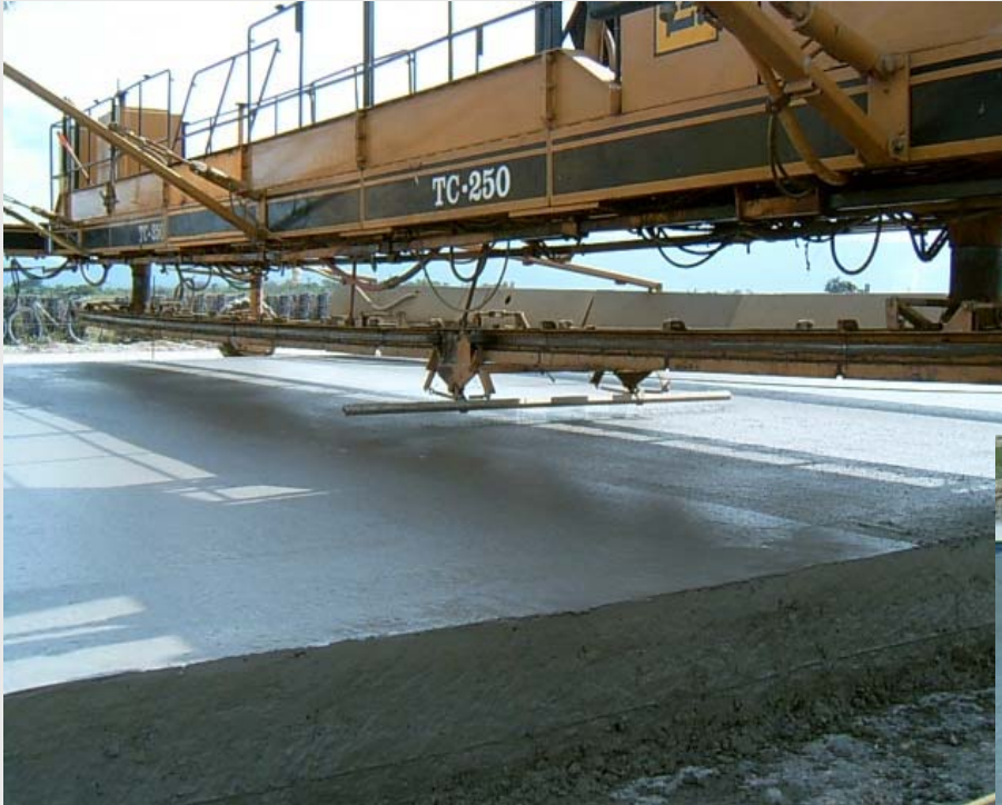
Durante el macro-texturizado de la Superficie de la losa de concreto
