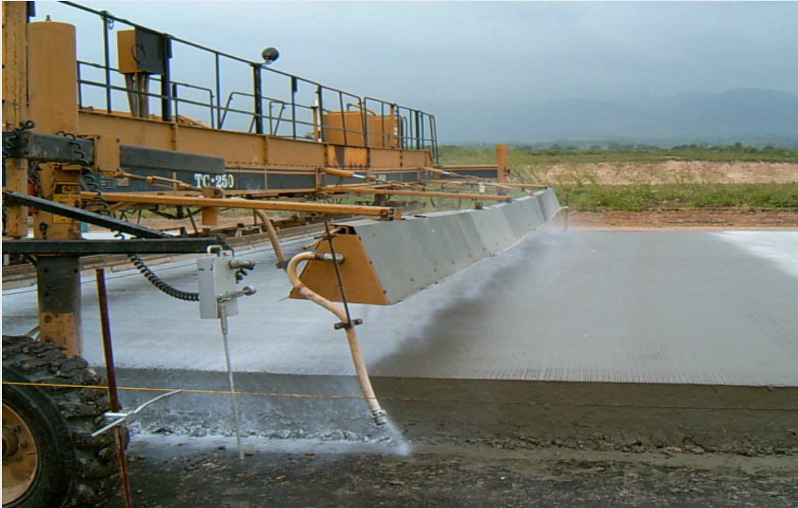
Aplicación de la membrana de curado sobre la superficie a razón de 0.50 lt/m 2 .
