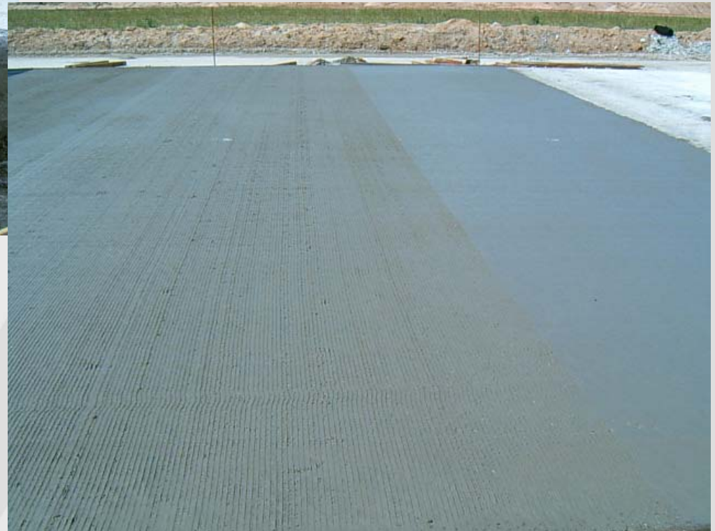
Acabado final de la losa de Concreto hidráulico
