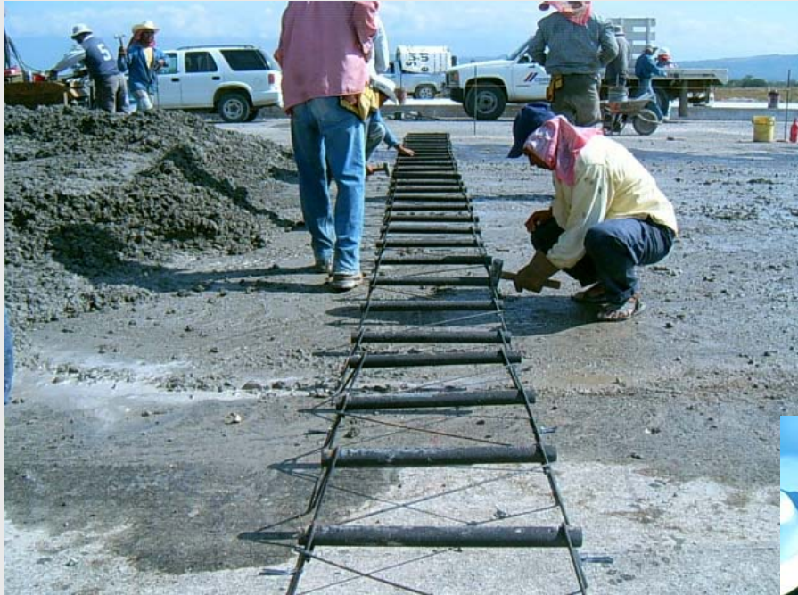
Fijación de las canastillas que soportan las barras pasa-juntas
