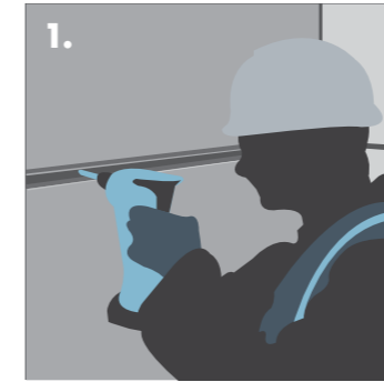
1. Fixing Knauf Perimeter Channel.
