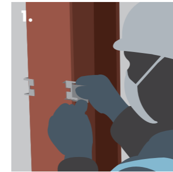
1. Installing Knauf Fixing Clips.
