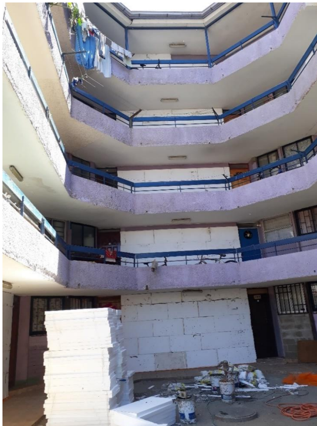
Figura 2-18. Instalación de planchas de Aislapol.
