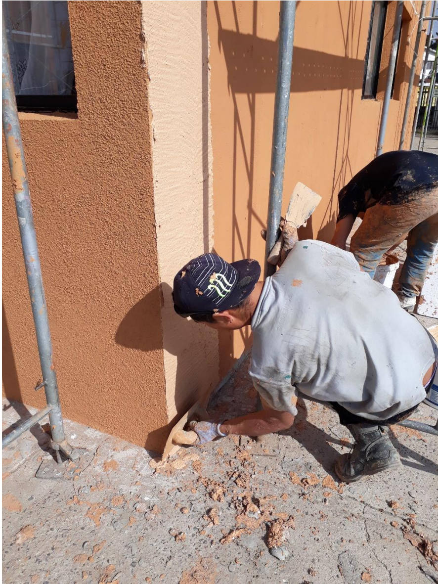
Figura 2-24. Aplicación de terminación con grano.
