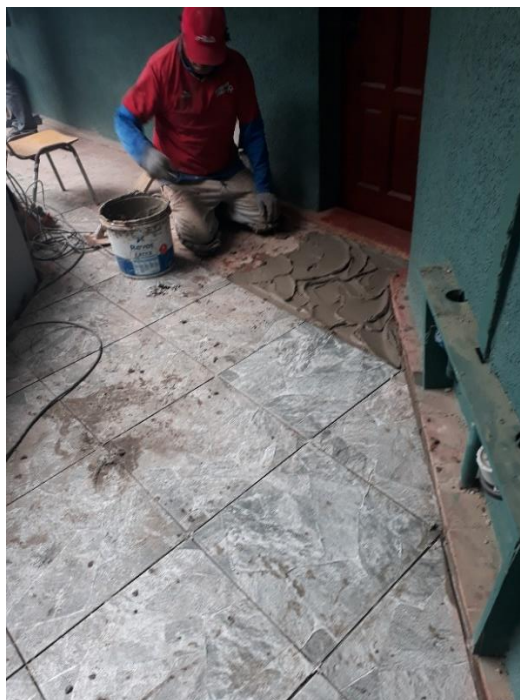
Figura 2-6. Parte del edificio sin modificaciones
