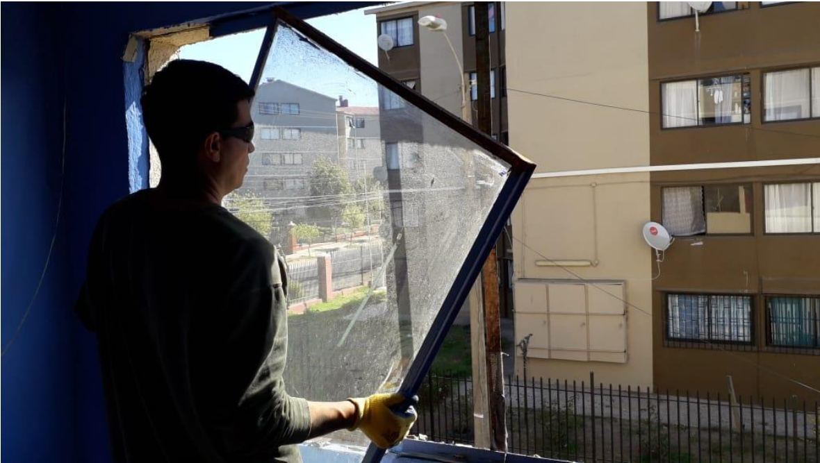
Figura 2-10. Extracción de antigua ventana de fierro oxidado
