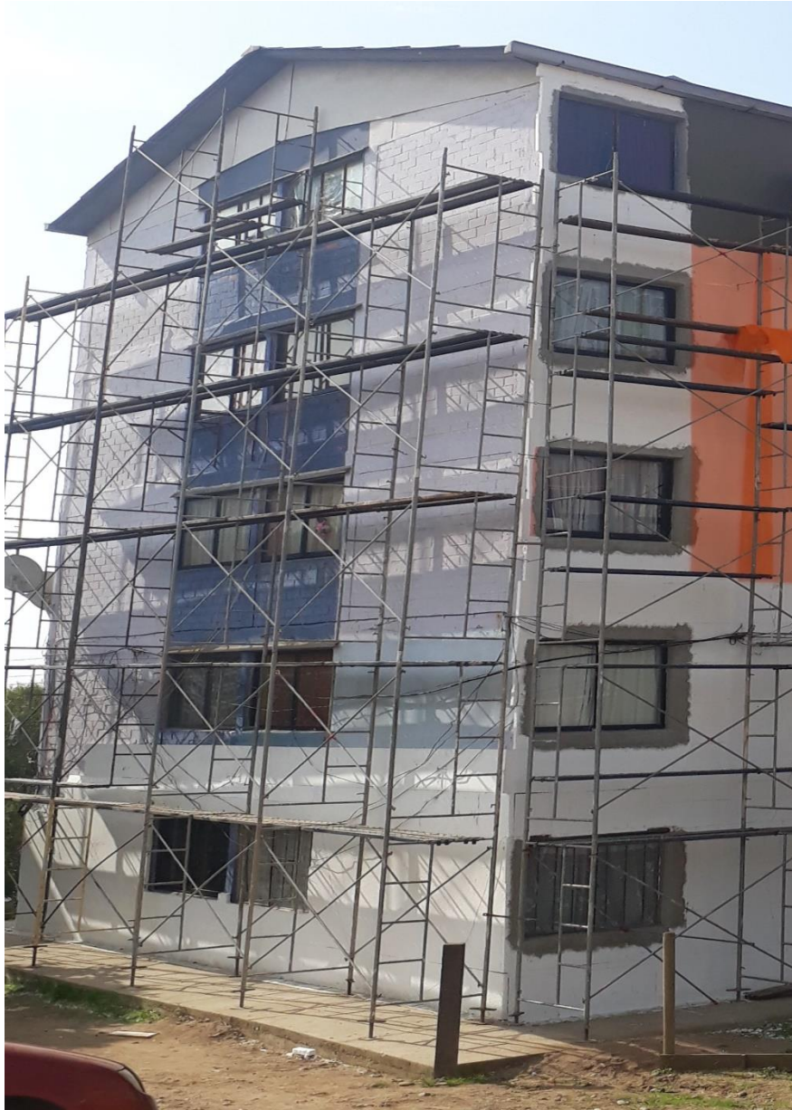
Figura 2-15. Andamios ya instalados para comienzo de pegado de Aislapol.
