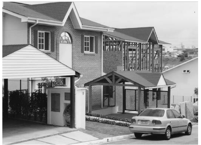
Foto 2.9 - Residencias construidas con el sistema Light Steel Framing en Cotia - São Paulo. (Fuente: Archivo del autor)
