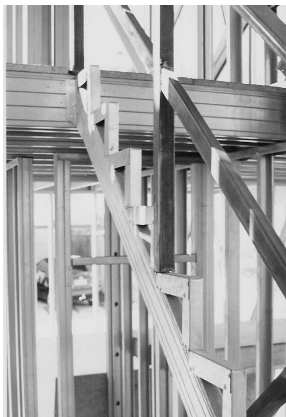
Foto 4.9 - Escalera viga cajón inclinada. (Fuente: Archivo del autor)
