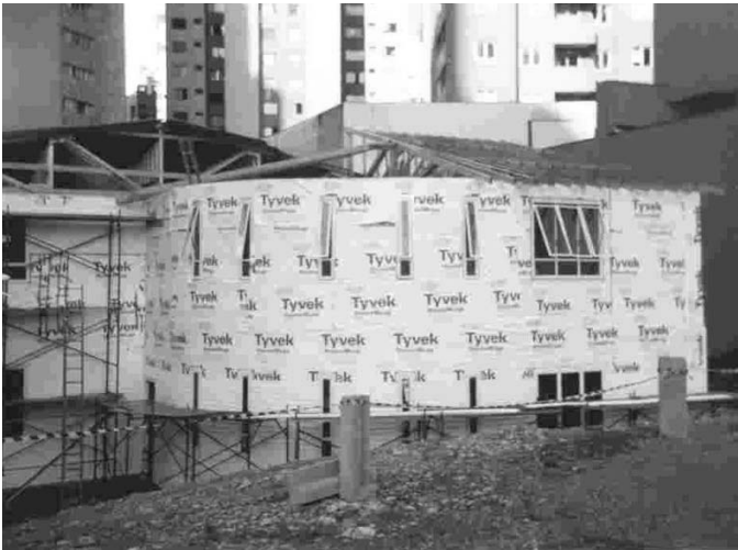
Foto 3.11 - Montaje de paredes curvas proyectadas para la construcción con perfiles conformados en frío en un dispensario en Curitiba. (Fuente: US Home)
