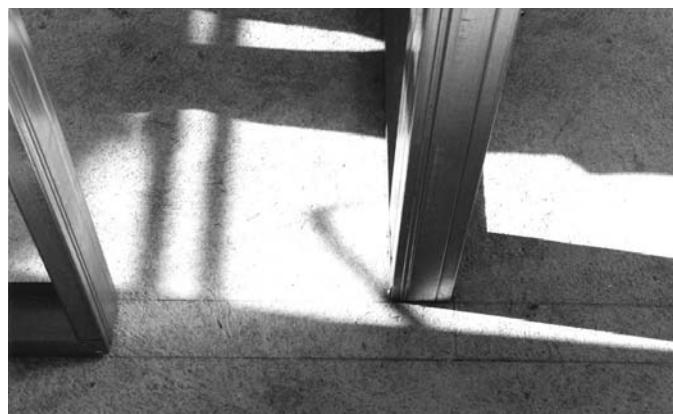
Foto 7.11 - Marcación de la localización de los paneles interiores. (Fuente: Archivo del autor)
