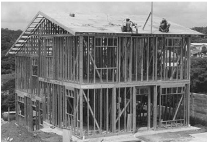
Foto 2.1- Estructura de una vivienda en Steel Framing, São Paulo. (Fuente: Construtora Sequência)
