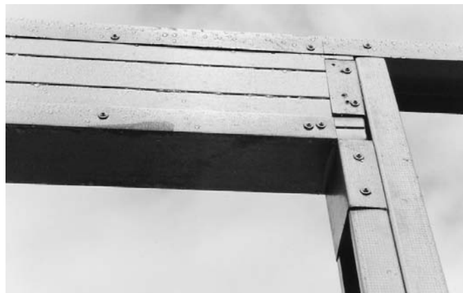
Foto 3.3 - Detalle de viga dintel para la abertura de ventanas. (Fuente: Archivo del autor)
