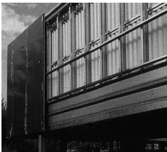
Foto 6.1- Cerramiento de edificación en SF con paneles de acero (Fuente: Revista Architecture à Vivre)
