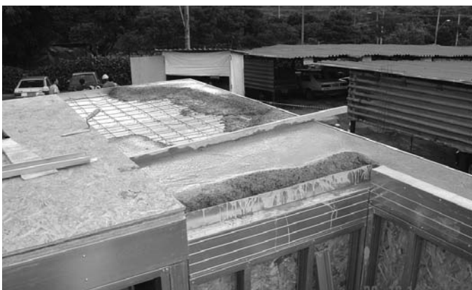
Foto 7.16 - Ejecución de losa húmeda. (Fuente: Usiminas)
