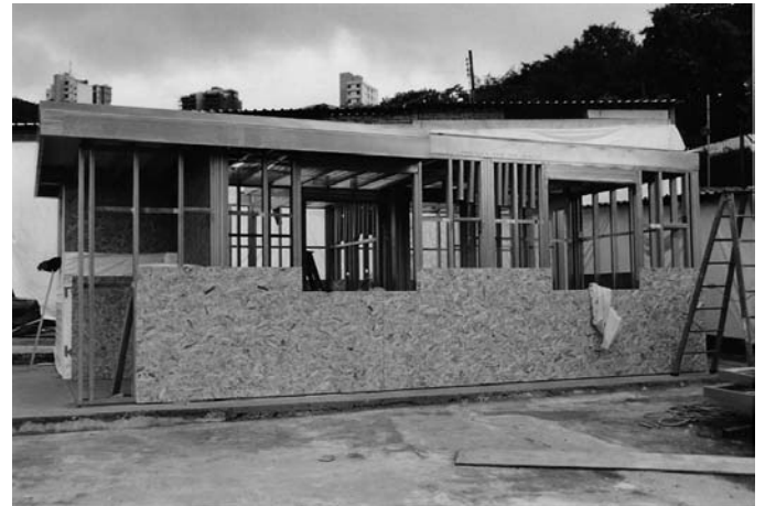
Foto 7.13- Colocación del cerramiento exterior de paneles. (Fuente: Archivo del autor)
