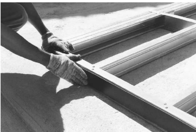
Foto 7.5 - Aplicación de la cinta sellante en la base del panel. (Fuente: Archivo del autor)
