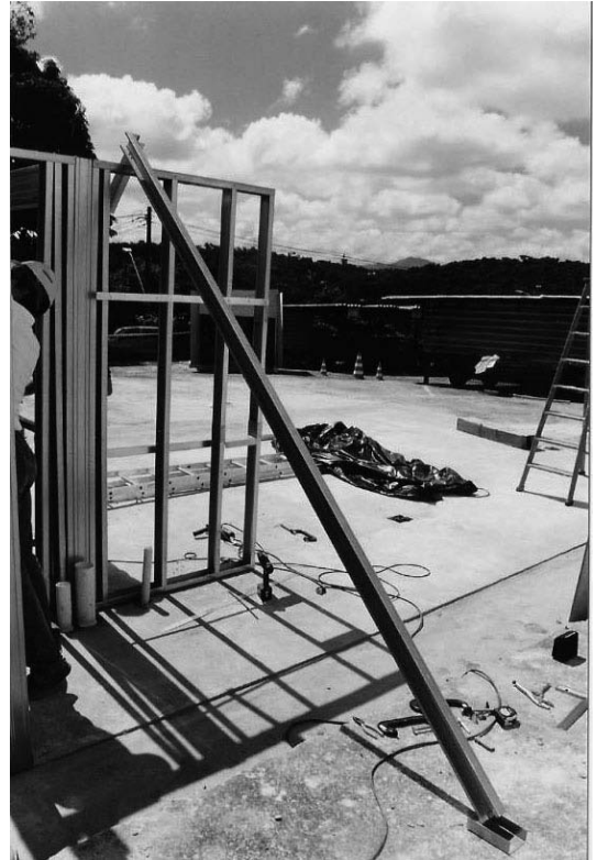
Foto 7.6 - Apuntalamiento del panel durante el montaje. (Fuente: Archivo del autor)
