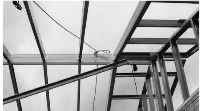
Foto 5.3 - Cumbrera compuesta de perfiles U y C como apoyo de los cabios (Fuente: Archivo del autor)
