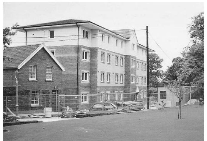
Foto 2.16 - Edificio en Inglaterra. (Fuente: SCI)
