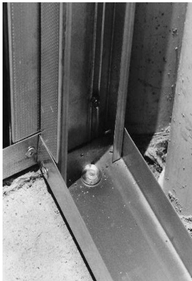
Foto 2.32 -Anclaje provisorio. (Fuente: Archivo del autor)
