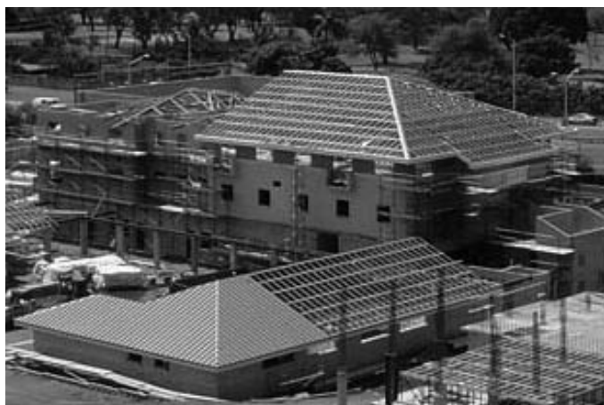
Foto 5.12 -Planchas de acero usadas en la cubierta de la edificación.(Fuente: mhttp://www.aegismetalframing.com ).
