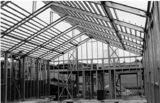
Foto 5.2 - Tejado estructurado con cabios en un Laboratorio de la Universidade Federal de Ouro Preto - MG (Fuente: Archivo Célio Firmo)
