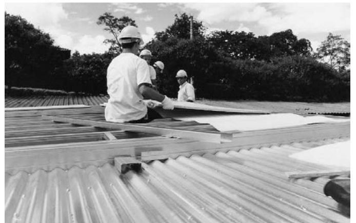
Foto 4.3 -Encofrado de acero para entrapiso húmedo (Fuente: Archivo del autor).
