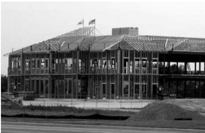
Foto 5.9 - Techo con intersección de varios planos. (Fuente: http://www.aegismetalframing.com ).
