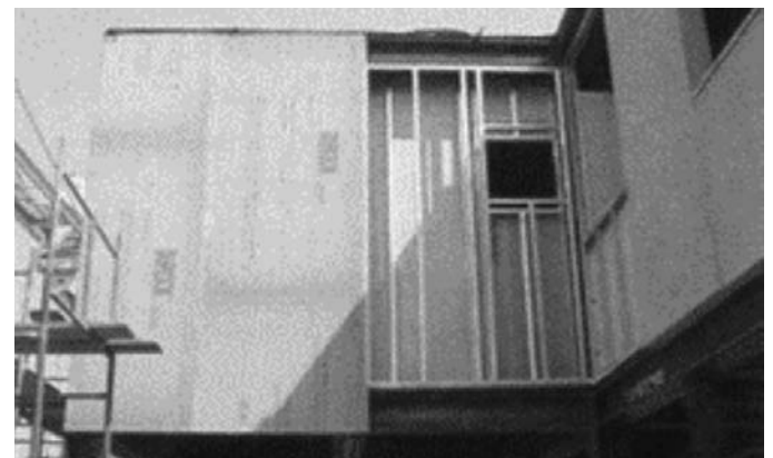
Foto 6.10 - Cerramiento con placas cementicias. (Fuente: Revista Techné n° 79)
