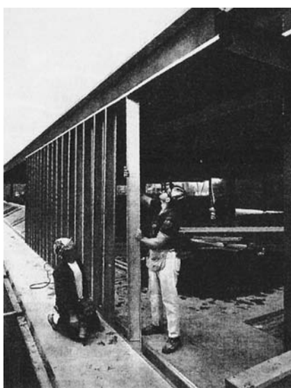
Foto 2.25-Steel framing montado mediante el método "Fabricación en obra" (Fuente: Robert Scharff).
