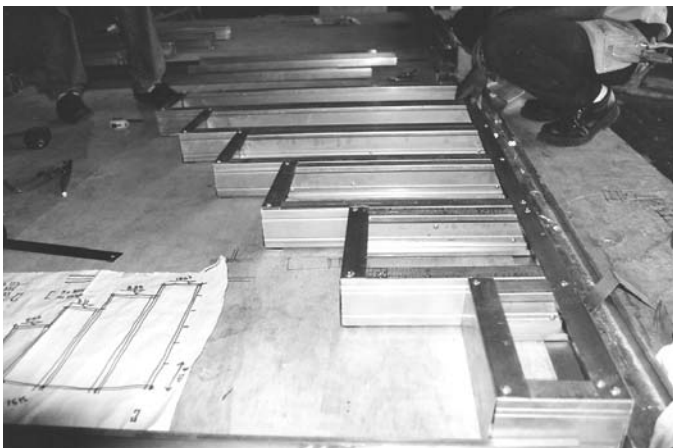
Foto 4.10 - Montaje de una escalera de paneles escalonados. (Fuente: Archivo del autor)
