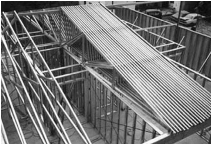
Foto 7.20 - Montaje de cabriadas de techo. (Fuente: Disponible en: http://www.consulsteel.com/cas/default.asp )
