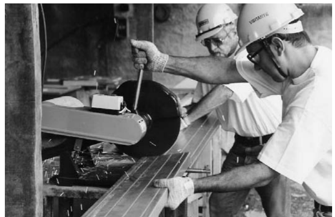
Foto 7.3 - Corte de los perfiles con sierra circular. (Fuente: Archivo del autor)
