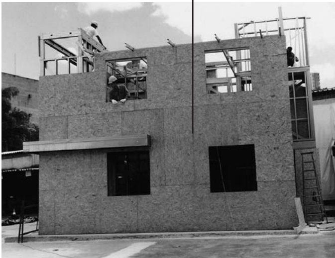
Foto 6.2 - Fachada con cerramiento exterior en OSB presentando juntas de dilatación. (Fuente: Archivo del autor)
