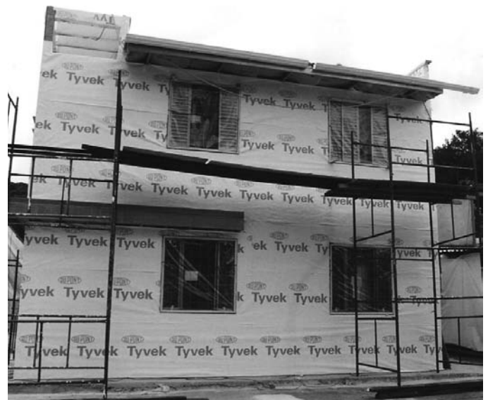
Foto 6.3- Impermeabilización de las placas de OSB de la fachada de la foto anterior con membrana de polietileno. (Fuente: Archivo del autor)
