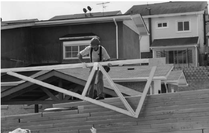
Foto 5.7 - Descarga de cabriada de tejado en la obra. (Fuente: Archivo del autor)
