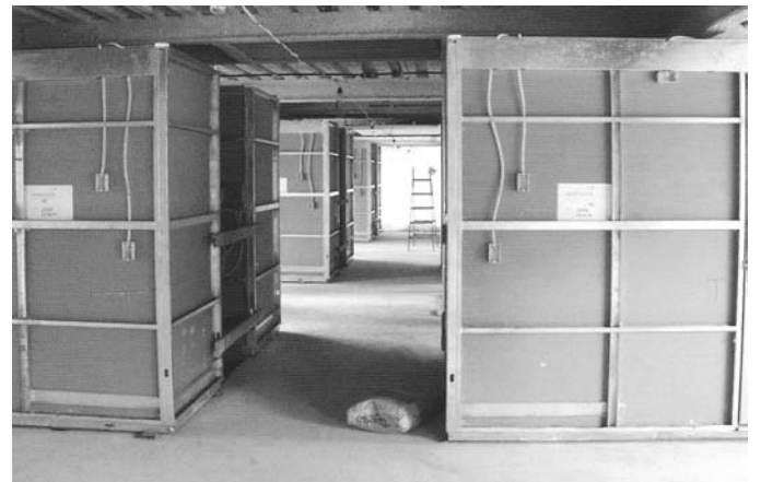
Foto 2.21 - Módulos de baños prefabricados y colocados en el Hotel Mondial Airport Business en São Paulo. (Fuente: Zigurate Editora) 2
