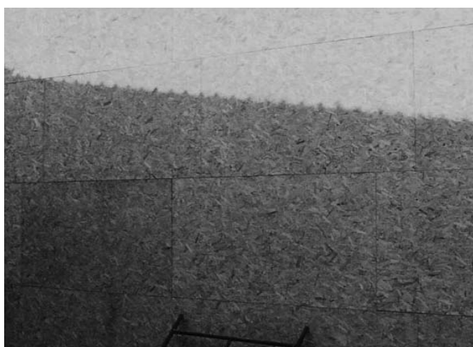
Foto 6.4- Instalación de OSB en la fachada con juntas verticales desfasadas. (Fuente: Archivo del autor)
