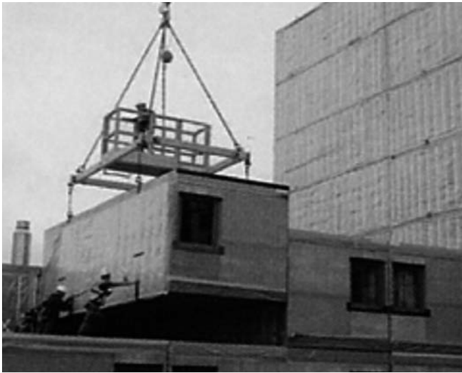
Foto 7.2- Unidades modulares siendo colocadas en la construcción (Fuente: disponible en: http://www.corusconstruction.com/page_9088.htm )
