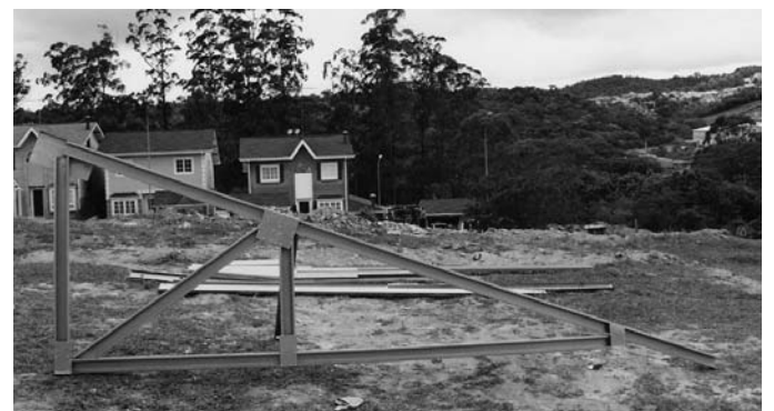
Foto 5.8 - Cabriada de "media agua" cuyos elementos están fijados en placas metálicas de acero (placas de Gusset). (Fuente: Archivo del autor)
