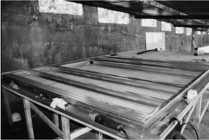
Foto 7.4 - Mesa de trabajo para el montaje de los componentes estructurales. (Fuente: Archivo del autor)
