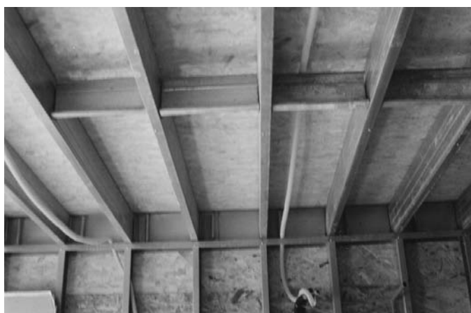
Foto 2.7 - Vista de la estructura del entrepiso con vigas de perfiles galvanizados y contrapiso en OSB. (Fuente: Archivo del autor).
