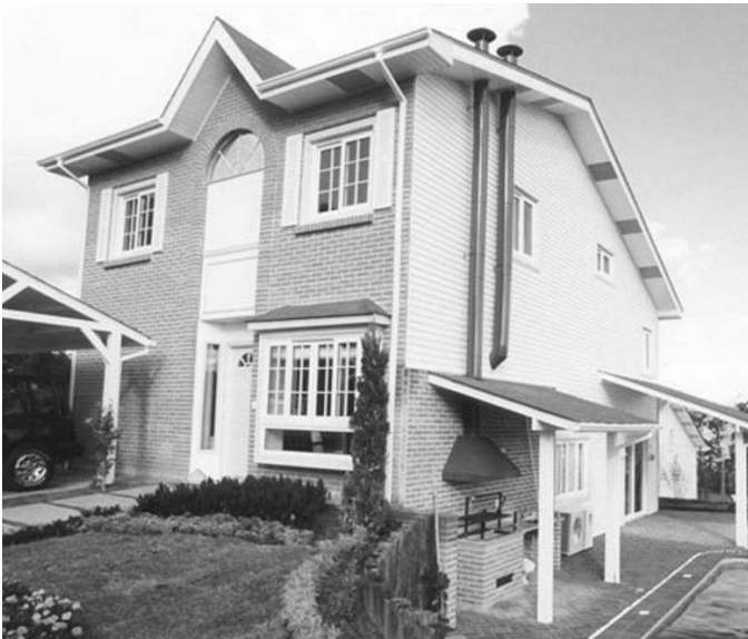
Foto 6.9 - Fachada revestida con ladrillos macizos a la vista. (Fuente: Disponible en: http://www.construtorasequencia.com.br )
