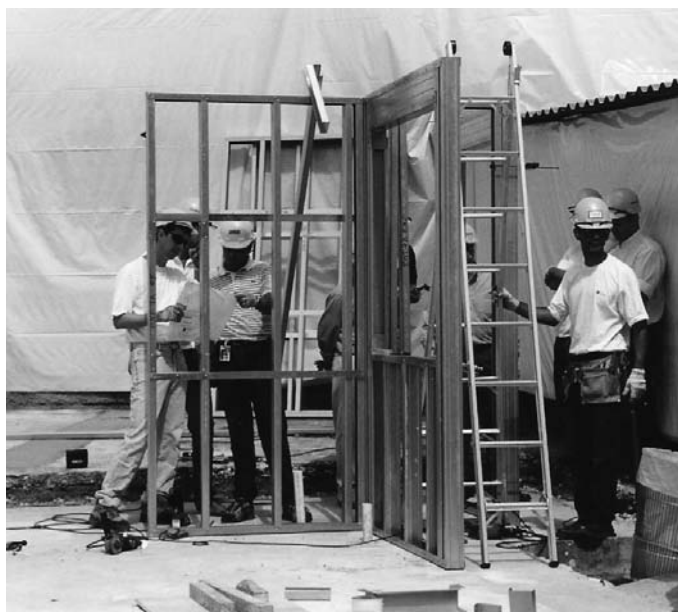
Foto 7.8 - Montaje de los paneles. (Fuente: Archivo del autor)
