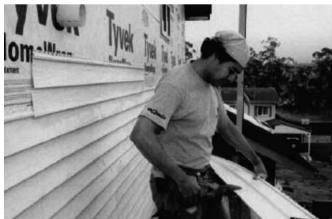
Foto 6.5 Instalación de siding vinílico. (Fuente: Marcos Lima 1 )
