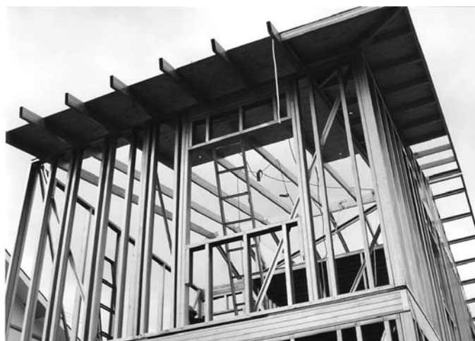
Foto 5.4 - Placas de OSB para la fijación de tejas "shingles" (Fuente: Archivo del autor)
