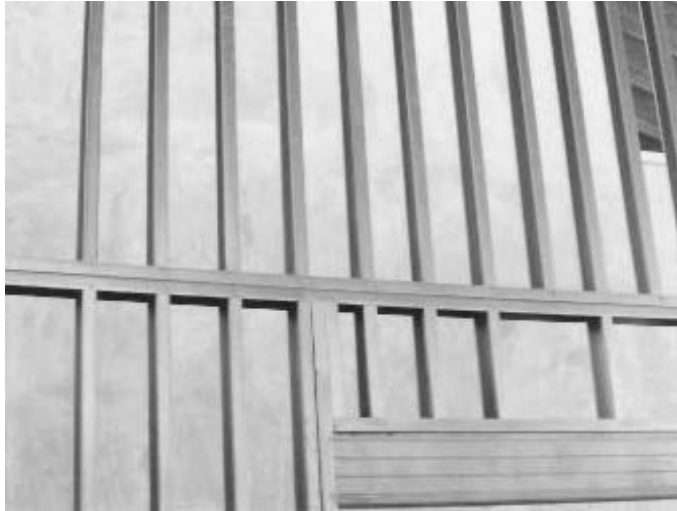
Foto 3.1- Panel cuya modulación es de 200 mm debido a la carga de estanque de agua (Fuente: Archivo del autor)
