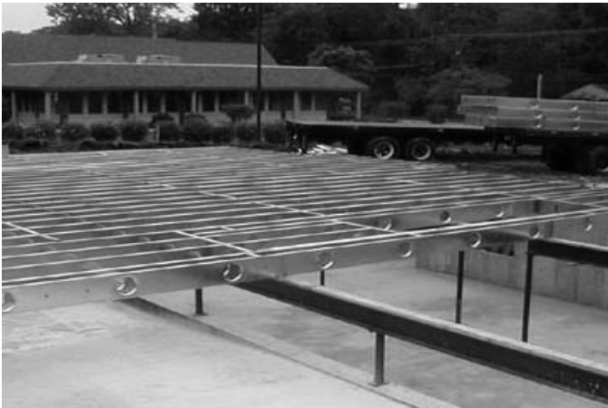
Foto 4.7- Vigas de entrepiso apoyadas sobre la viga principal de a acero. (Fuente: disponible en: http://www.aegismetalframing.com .)
