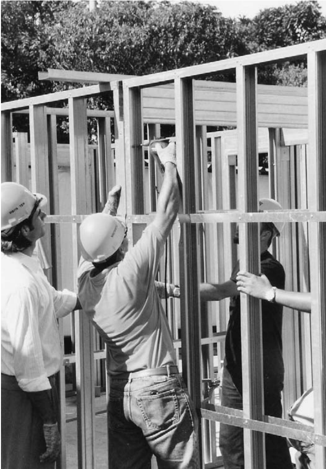
Foto 7.12 - Fijación de dos paneles con tornillos estructurales. (Fuente: Archivo del autor)
