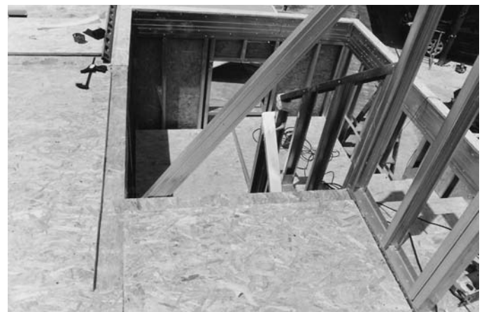
Foto 4.4 - Placas de OSB utilizadas como entrepiso seco. (Fuente: Archivo del autor)
