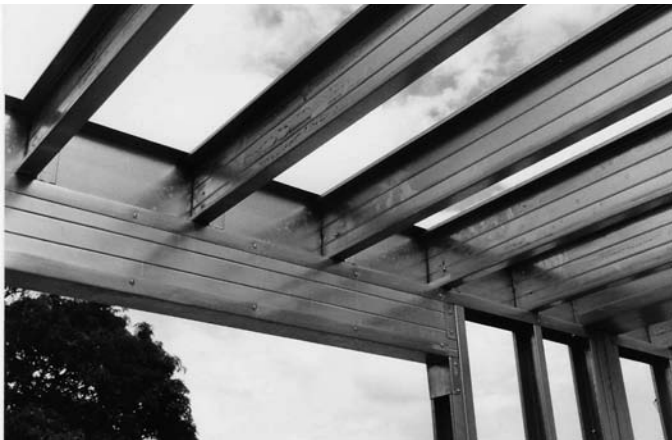
Foto 7.15 - Posicionamiento de las vigas de entrepiso en la cenefa. (Fuente: Archivo del autor)
