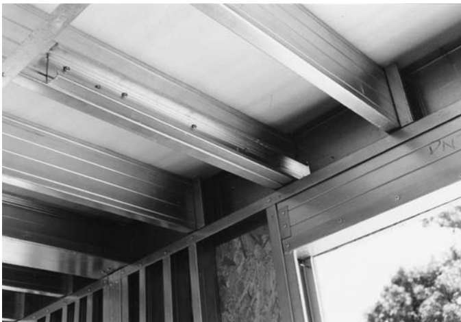
Foto 4.5 - Film de polietileno entre vigas de entrapiso y contrapiso con placas de OSB. (Fuente: Archivo del autor)
