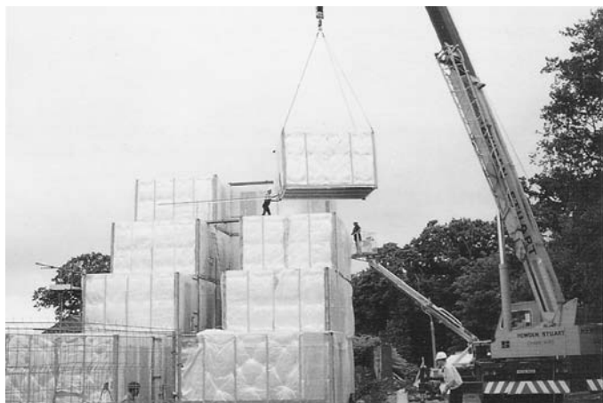
Foto 2.27 - Unidades modulares apiladas de acuerdo a la construcción final, el espacio que se ve al centro formará la vía de circulación de acceso a las unidades. (Fuente: SCI)
