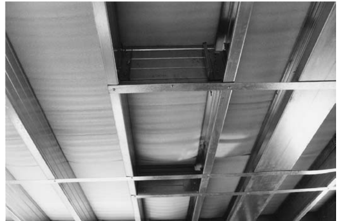
Foto 4.8 -Rigidización horizontal de entrepiso por medio de bloqueadores y cintas metálicas (flejes) (Fuente: Archivo del autor)
