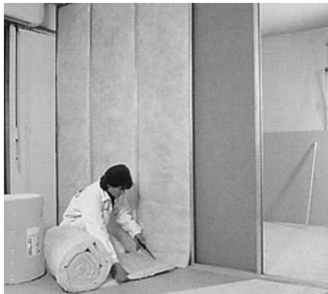
Foto 6.11 - Instalación de lana de vidrio en un panel
