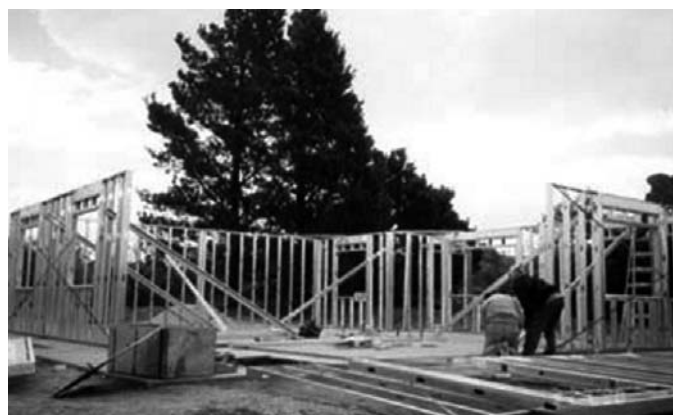
Foto 7.10 - Montaje de los paneles exteriores (Fuente: Disponible en: http://www.consulsteel.com/cas/default.asp )
