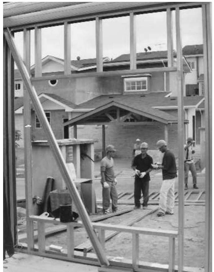
Foto 3.10 - Panel no-estructural de fachada de residencia. (Fuente: Archivo del autor)
