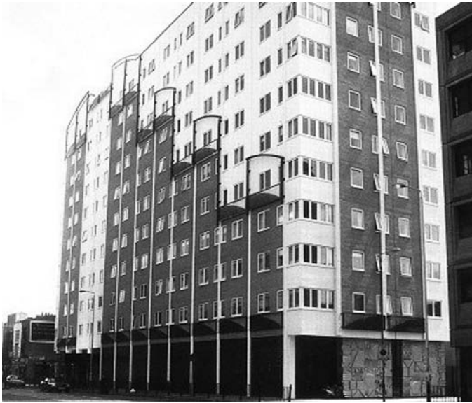
Foto 2.22 - Reforma de fachada usando Steel Framing. (Fuente: disponible en: http://www.steel-sci.org/lightsteel )
