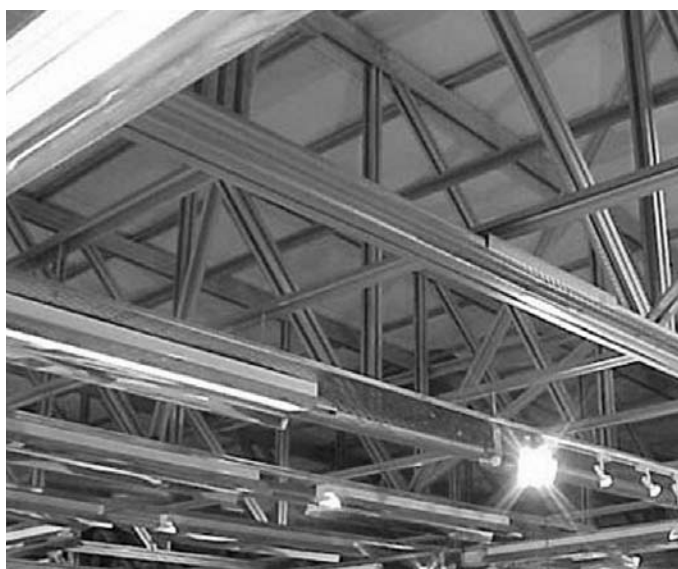
Foto 5.1- Vigas de Celosía planas . (Fuente: http://www.aegis-metalfra-ming.com ).
