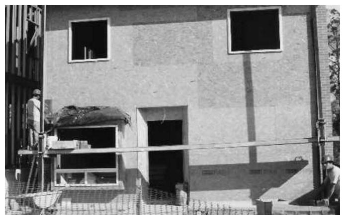
Foto 3.8 - Cerramiento de fachada con placas de OSB. (Fuente: Archivo del autor)
