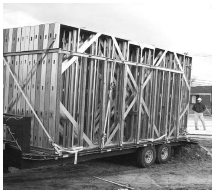
Foto 2.26- Elementos estructurales como cerchas y paneles son prefabricados en plantas de prefabricación y llevados a la obra para el montaje de la estructura. (Fuente: http://www.aegismetalframing.com ).
