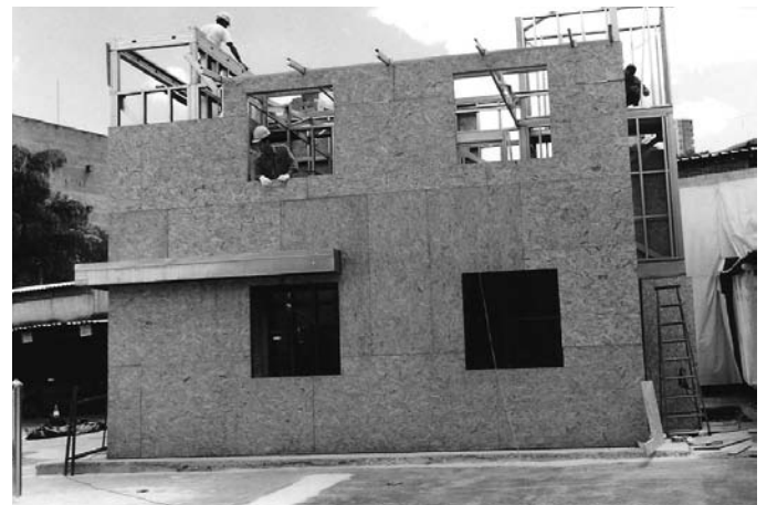
Foto 7.14 - Las juntas de placas deben estar desfasadas. (Fuente: Archivo del autor)
