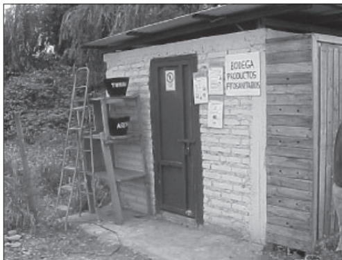
Sistema de ventilación menos eficiente.
