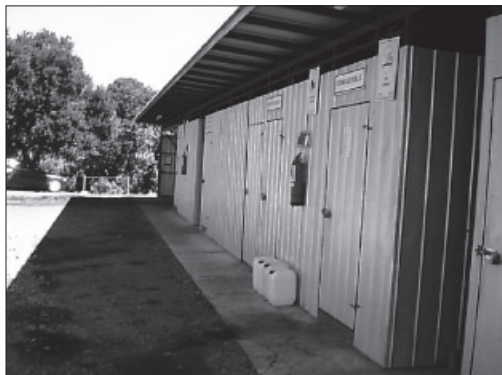
Sistema de ventilación más eficiente.
