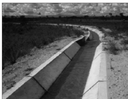
Canal revestido en concreto.
