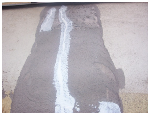
Figura N° 2.11: Aplicación de pasta acrílica en zona de la grieta
