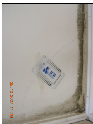
Figura N° 2.9: Fisuras en albañilería de HCA
