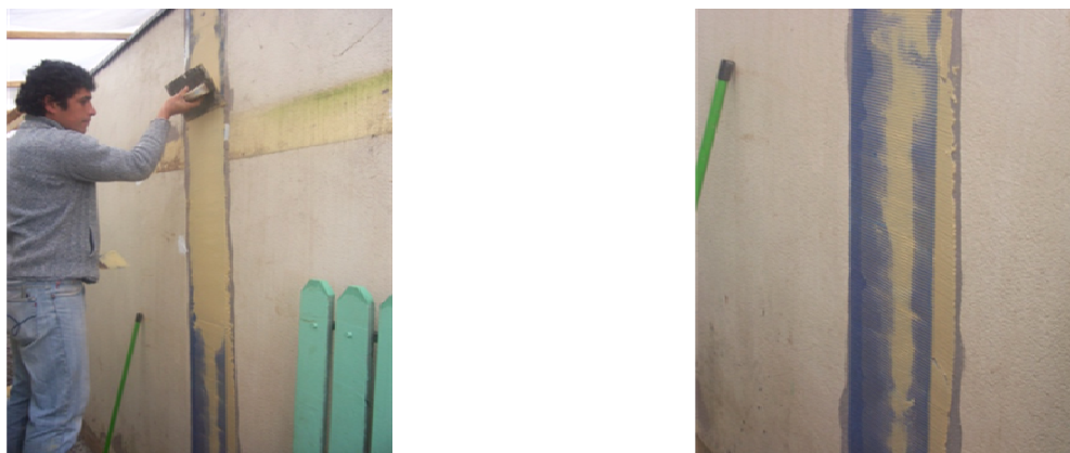
Figura Nº 2.12: Colocación de malla de fibra de vidrio
