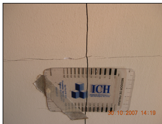
Figura N° 2.9: Fisuras en albañilería de HCA
