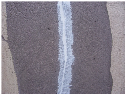
Figura N° 2.11: Aplicación de pasta acrílica en zona de la grieta
