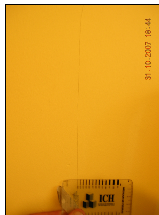
Figura N° 2.8: Fisuras verticales en albañilería de HCA
