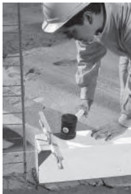
Figura N° 3.1: Primera hilada e hiladas sucesivas traslapadas
