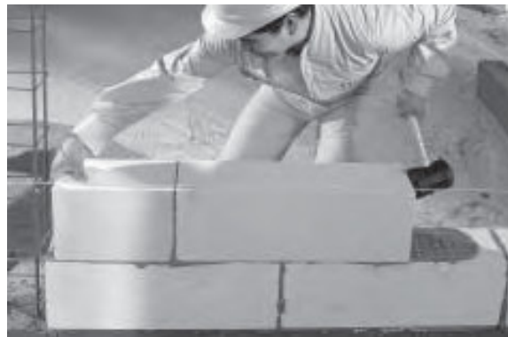
Figura N° 3.1: Primera hilada e hiladas sucesivas traslapadas
