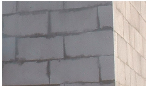
Figura N° 3.4: Trabazón de muros perpendiculares
