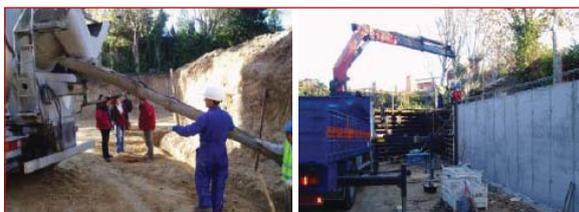
**Figura 8.73. Puesta en obra del hormigón.**
