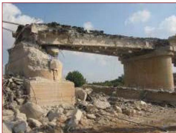
**Figura 8.74. Demolición selectiva.**
