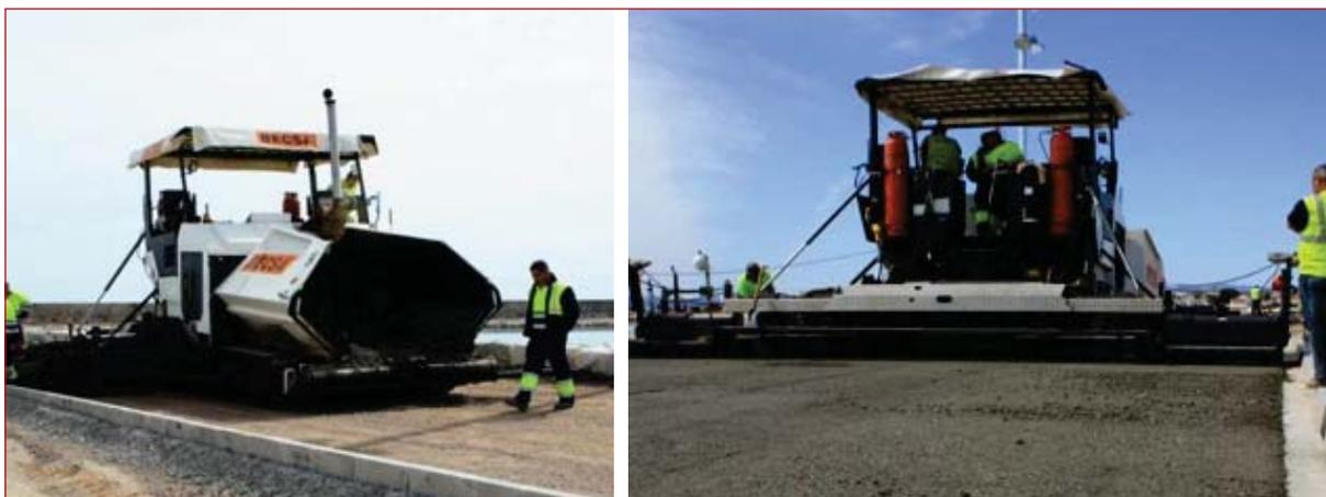
**Figura 8.51. Extendidora TITAN 525.**
