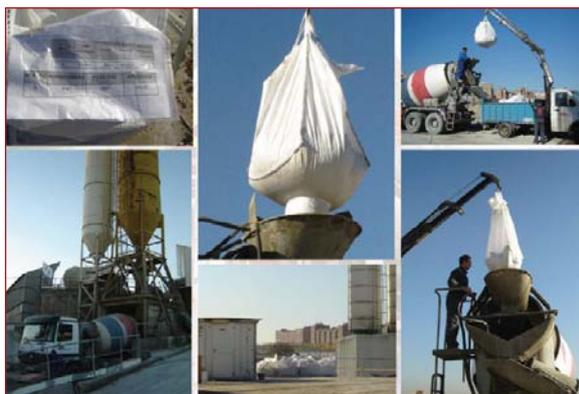
**Figura 8.72. Fabricación del hormigón en central.**
