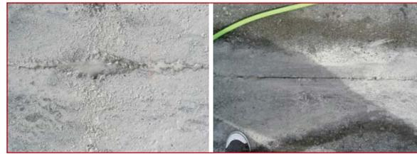
Figura 8.62. Aspectos de las juntas de retracción.
