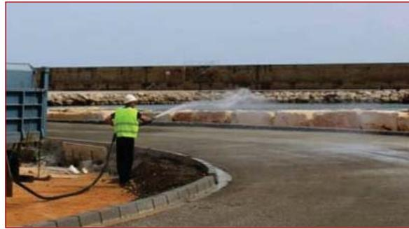
Figura 8.57. Curado del hormigón.
