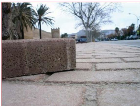
**Figura 8.5. Adoquín fabricado a partir de árido reciclado por la empresa Pastor, S.A.**
