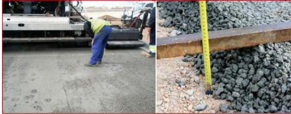
**Figura 8.45. Medición del descenso tras la compactación del tramo de prueba.**
