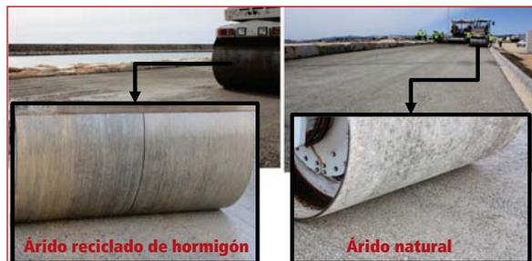
Figura 8.58. Aspecto del hormigón durante la compactación.
