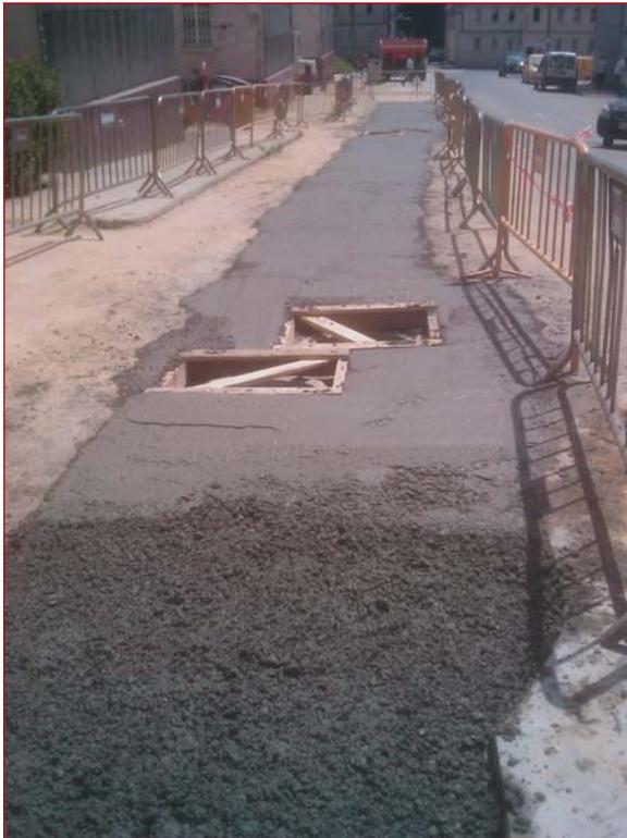
Figura 8.83. Hormigón realizado con gravilla mixta.
