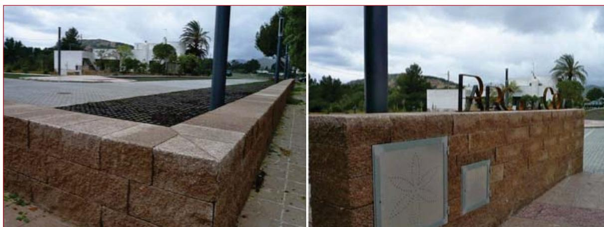
**Figura 8.27. Muro construido a partir de bloques prefabricados con áridos reciclados.**
