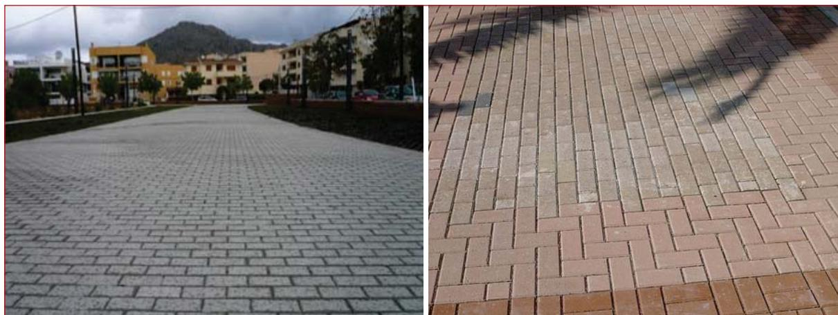
**Figura 8.26. Tramo de pavimento realizado con adoquines fabricados a partir de áridos reciclados.**
