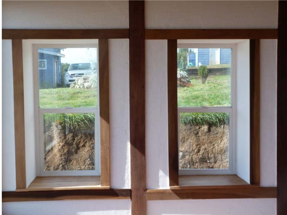
Ventanas Interiores con la Profundidad que otorga el Fardo.
