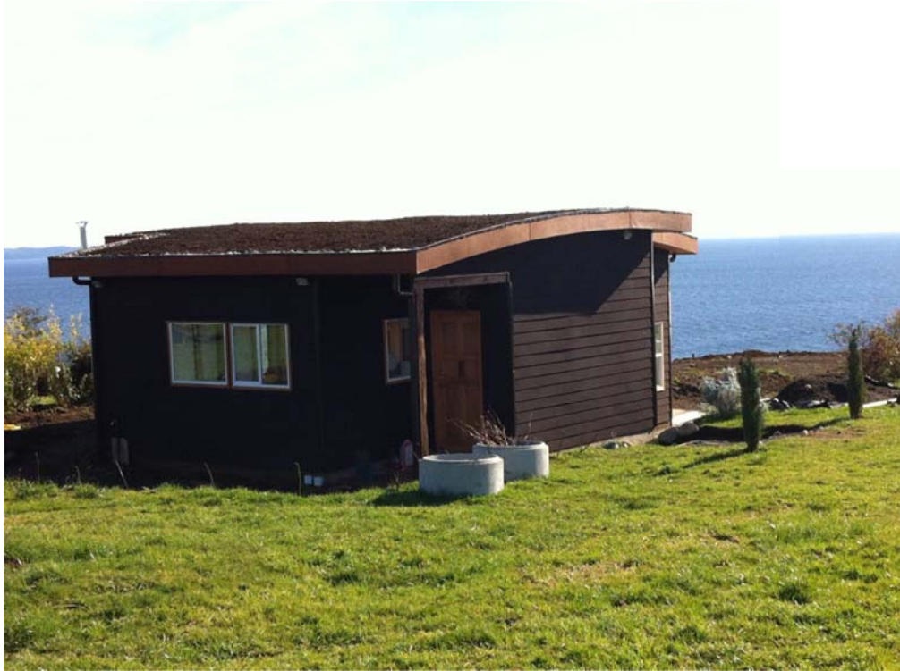
Exterior, Fachada Sur
