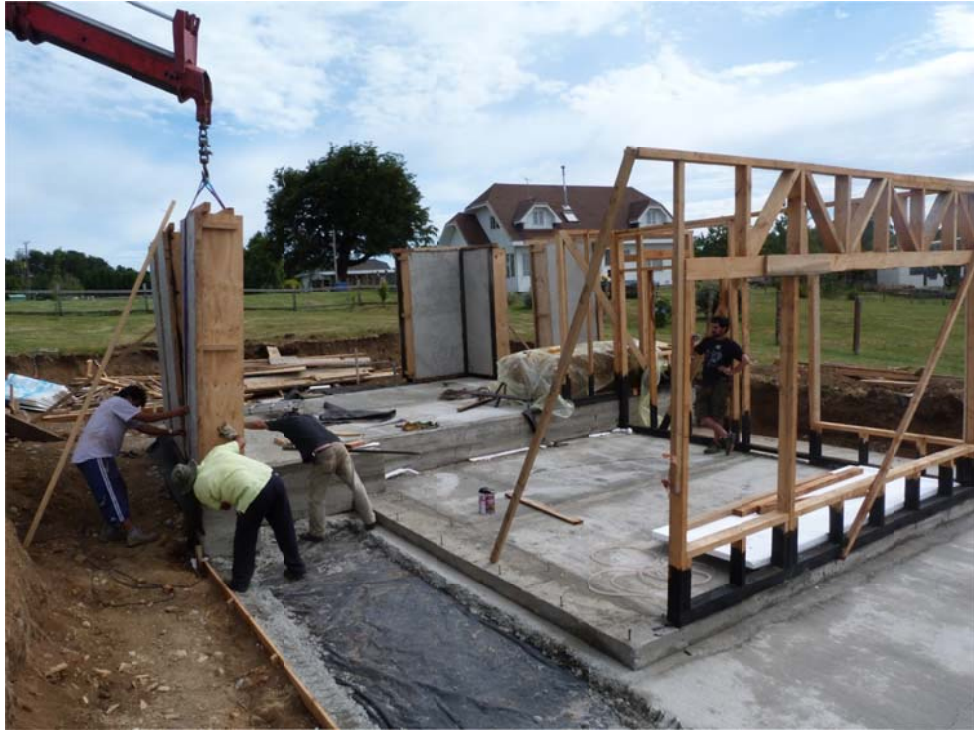
Instalación de Paneles en obra.
