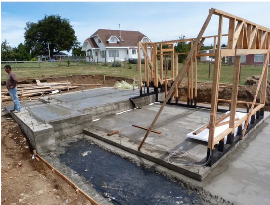
Proyecto Cabaña Ensenada previo a la instalación de los módulos
