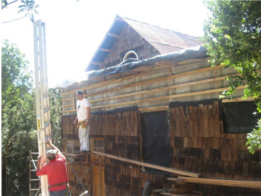
Colocación de tejas recicladas
