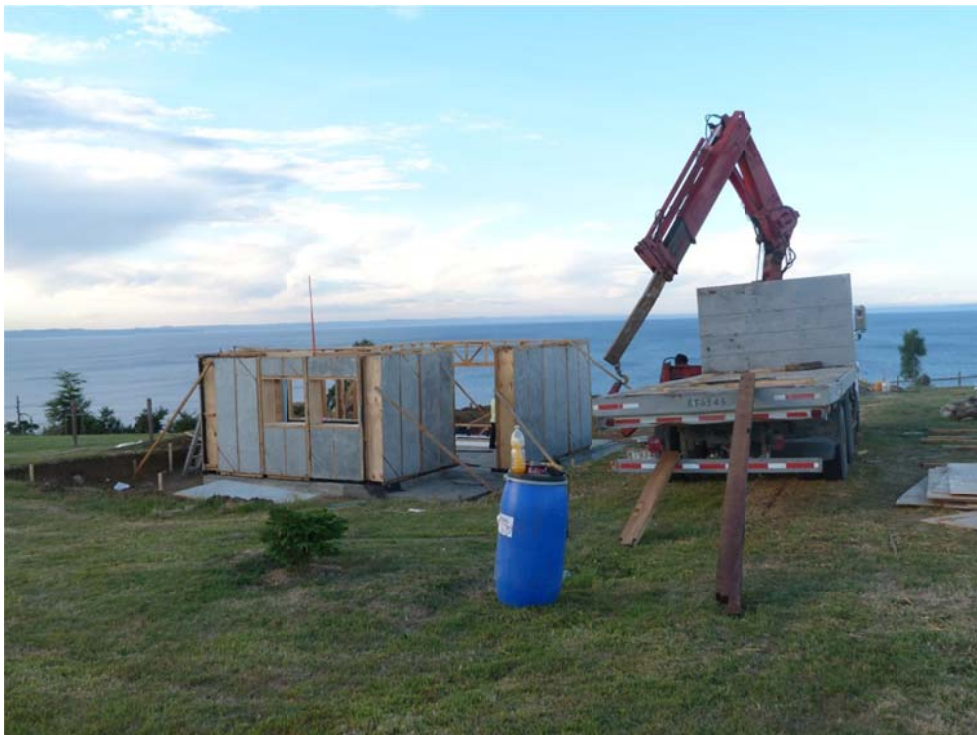
Paneles instalados en obra.
