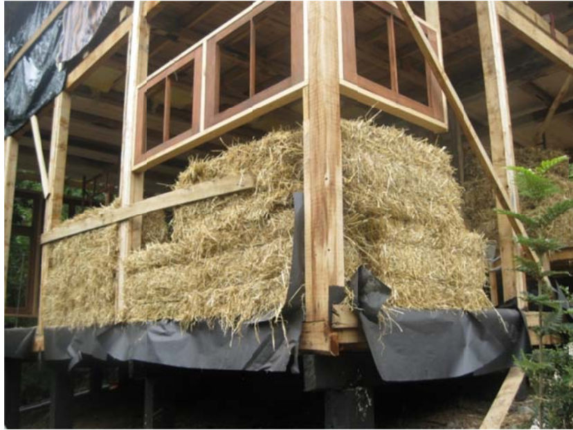
Proceso de construcción, Colocación de fardos sobre radier.
