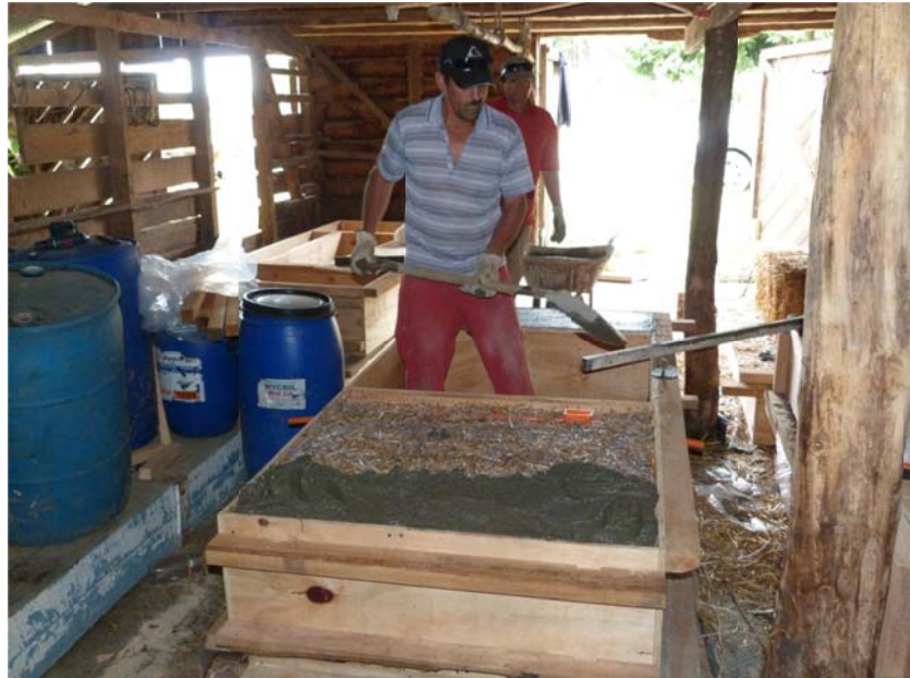
Estuco del modulo con los fardos en su interior
