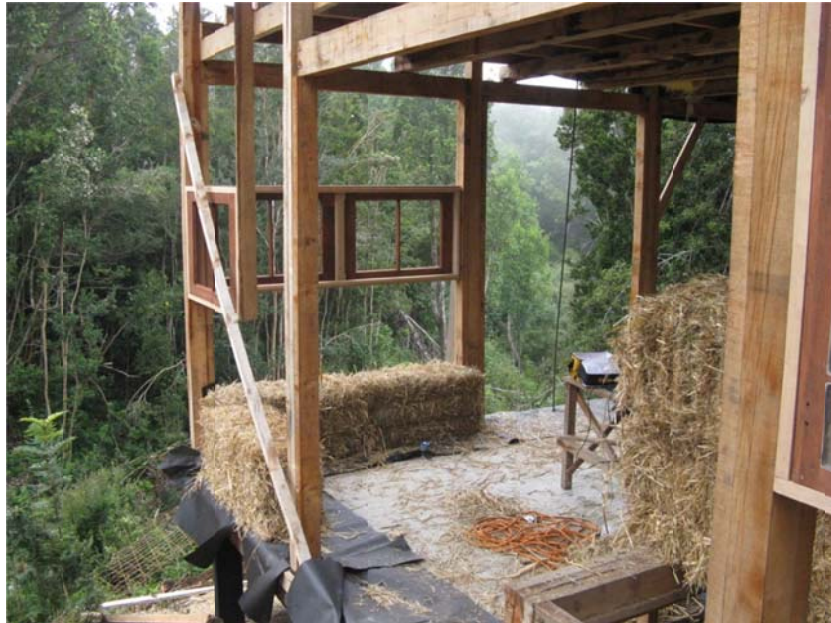
Proceso de construcción, Colocación de los Fardos.
