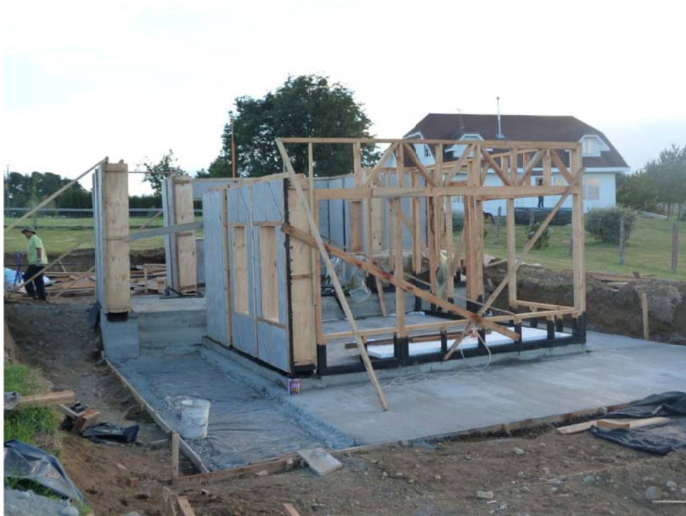
Trabajo de instalación de Paneles terminado
